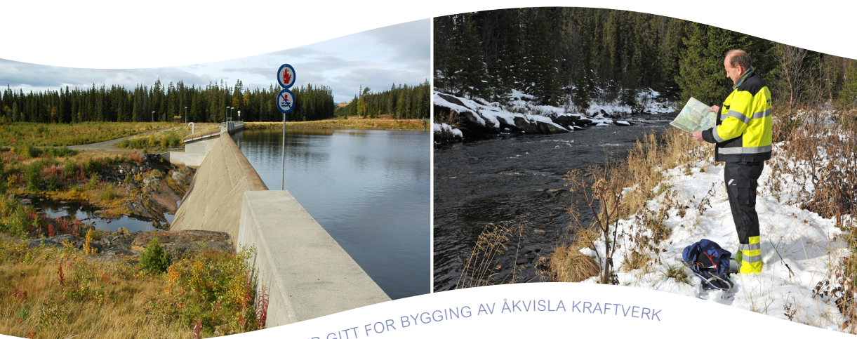
Åkvisla inntaksdam (t.v.), og elva Åkvisla (t.h.), der Stein Kotheim studerer plasseringen av det nye kraftverket.
