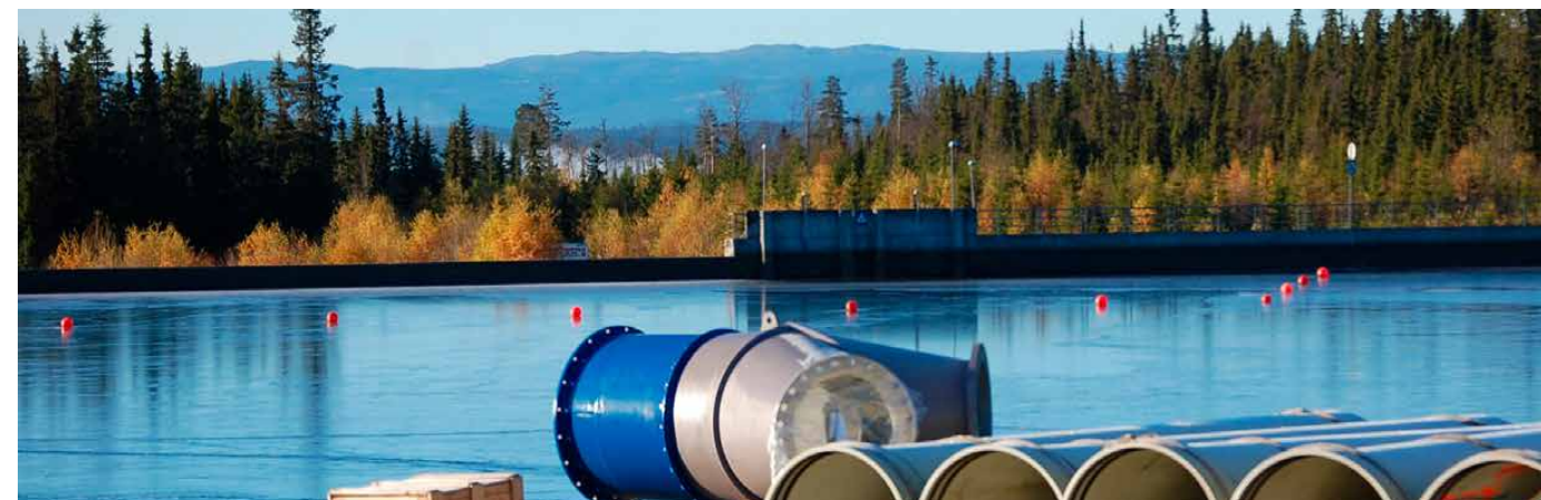
Fra Åkvislautbyggingen; Moksa inntaksdam.
