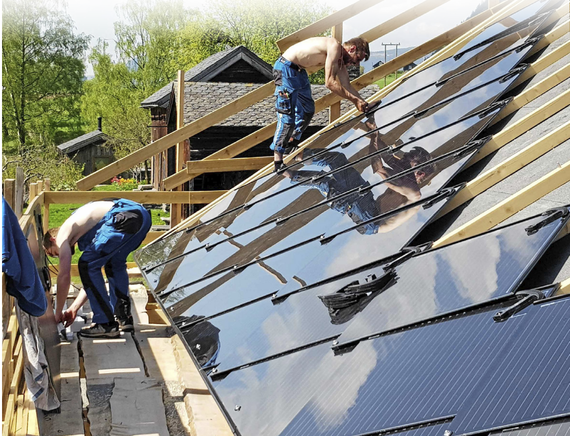
Erstatning: Solceller som erstatning for skifer legges på fjæset fra 1872. Totalt 198 paneler.
