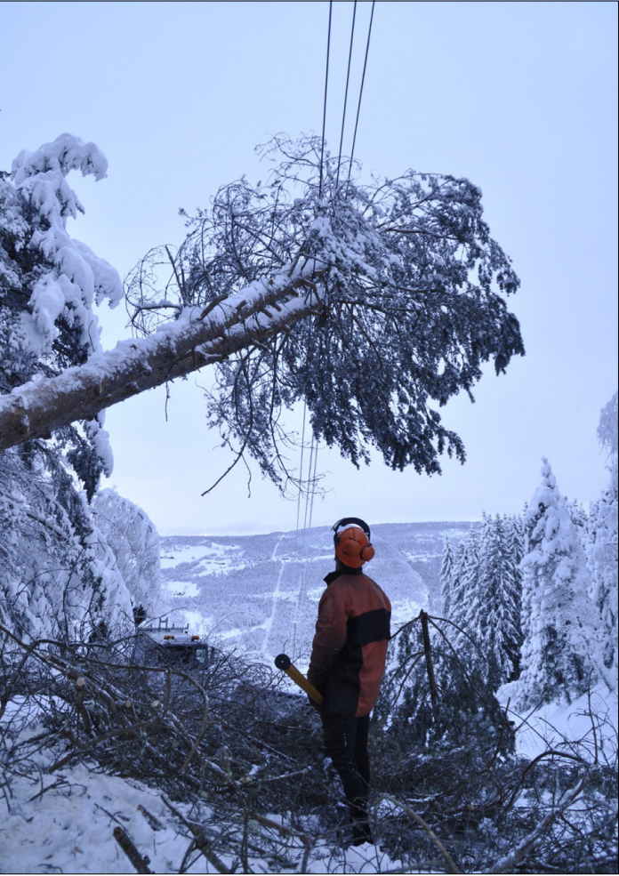
TREFALL: Et kjent syn for linjerydne, og bare ett av flere trefall over linjennettet til Gudbrandsdal Energi den siste uka. Alle foto: Tor Larsen.
