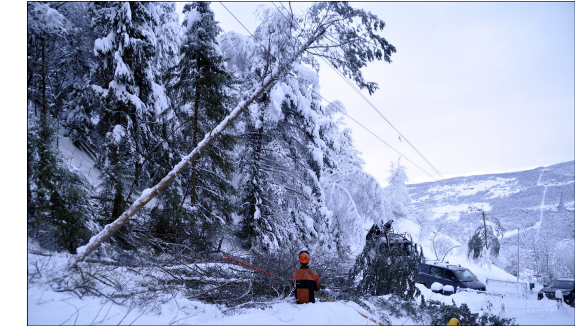
LINJERYDNING: Det er mange eventualiteter å ta hensyn til. Hvor skal treet kuttes, og hva gjør det med vektfordelingen? Hvilken retning vil treet falle? Her ble den improviserte løsningen å ta toppen av treet og la den seile på linja nedover et stykke.
