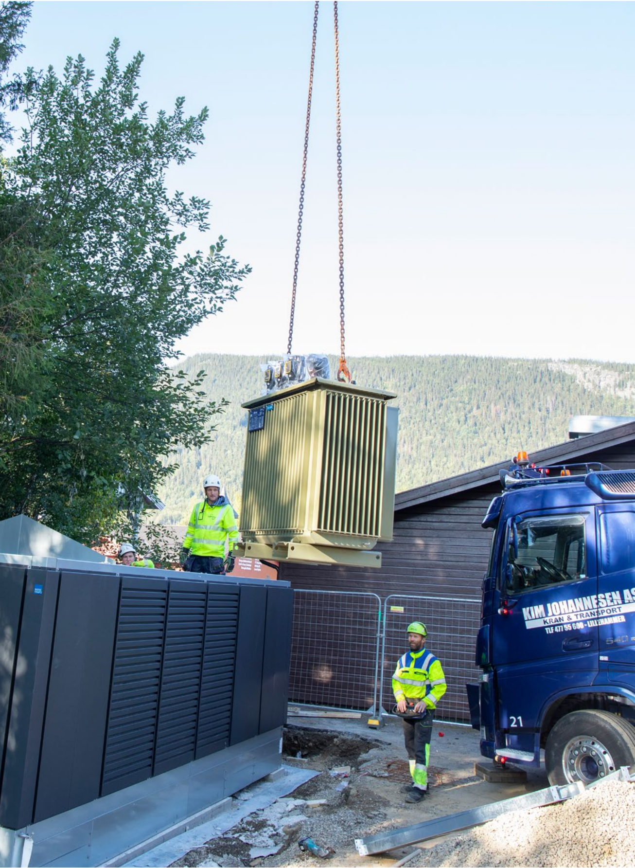
Håvard Tronstad monterer ny nettstasjon for elbilladere ved Coop Øyer. Foto: Nils Ormvold.
