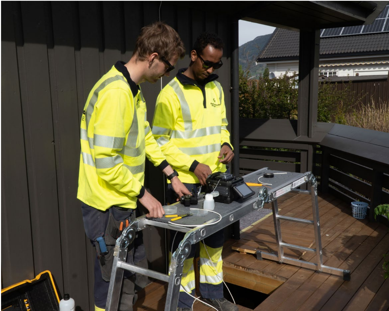
Fibermontørene Håvard Tangen (t.v.) og Ahmed Hassan i gang med fibertilknytning av et bolighus på Hundorp. Foto: Anette Slåstuen Haug
