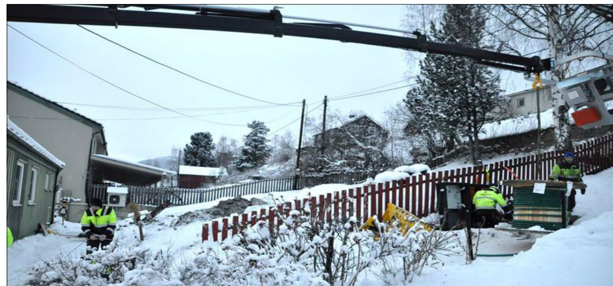
BREIBANDUTBYGGING: Nord-Fron bevilger ekstra med penger til breibandutbygging, og vil ha fullt breibanddekning i kommunen så snart som råd. Bildet er fra utbygging i Nedregate på Vinstra. Foto: Tor Larsen
