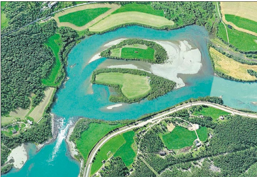
DAMOMRÅDE: Et mulig damområde kan være ved toppen av Vikafossen. Årsproduksjonen for Vikafossen kraftverk er i størrelsesorden 160-210 GWh, som tilsvarer strømforbruket til om lag 10 000 husstander, opplyser Hafslund Eco til GD.
