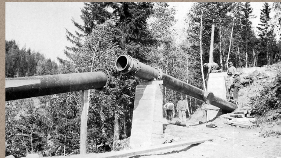
Fra monteringen av rørgata 1. juni 1921
