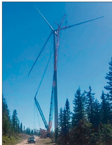
SISTE TURBIN: Her blir den aller siste turbinen montert.
