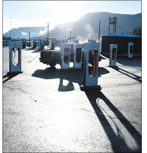
SAMARBEID: Ladeanlegget på Fåvang har kapasitet til å hurtiglade 32 elbiler. Det er BKK og Tesla som står bak satsingen.
