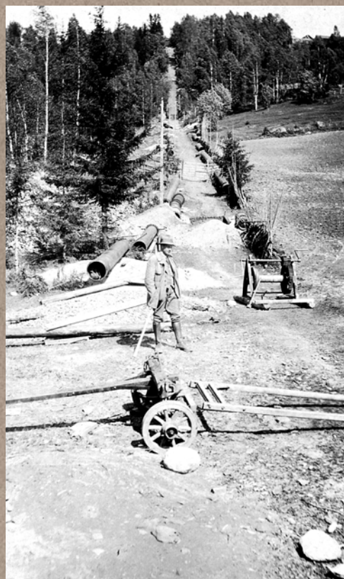
Rørtrasé mellom forankring 6 og 10. 1. juni 1921.
