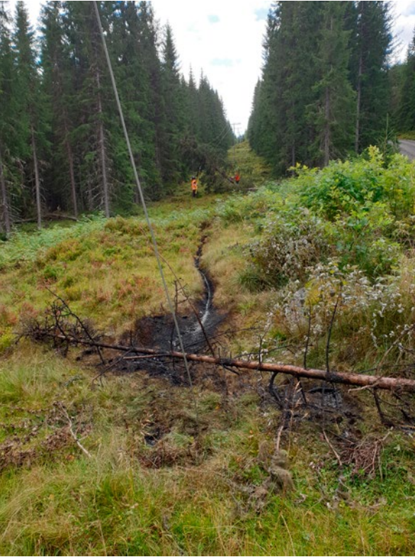
Fra arbeid med å gjenopprette strømforsyningen etter svært kraftige vindkast i august. Bildet viser tydelig at strømledninger på bakken er livsfarlige. Foto: Håvard Tronstad.
