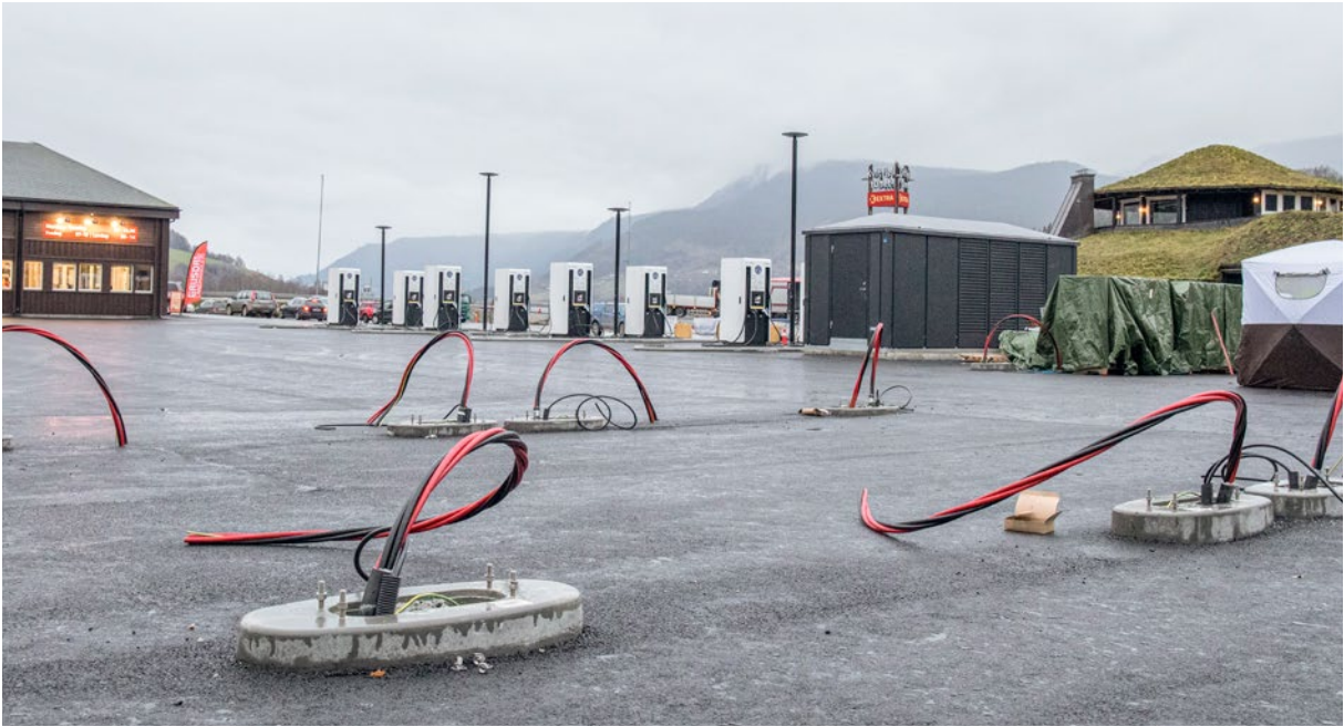
Det grønne skiftet trenger mye strøm. Her fra utbygging for lading av elbiler på Kvitfjell, som samlet bruker over 5 MW. Foto: Nils Ormvoid
