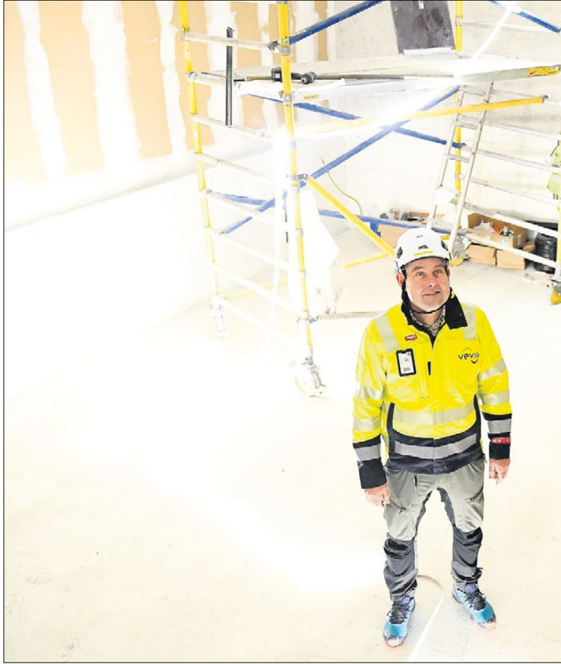
STOR UTBYGGING: Det er snart 20 år siden sist det ble bygd noe tilsvarende her i distriktet. - Hadde det ikke vært for
