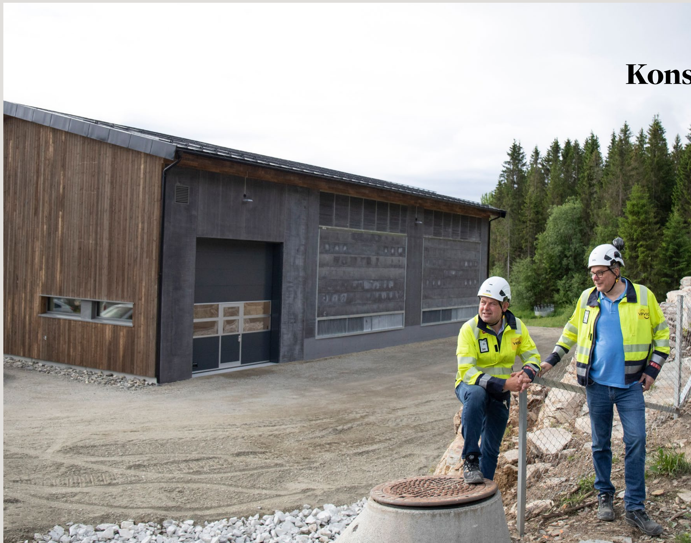
Prosjektleder Arne-Ivar Myrvang og daglig leder i Vevig Johannes Bergum ved den nye Fåvang trafostasjon. Foto: Nils Ormvold
