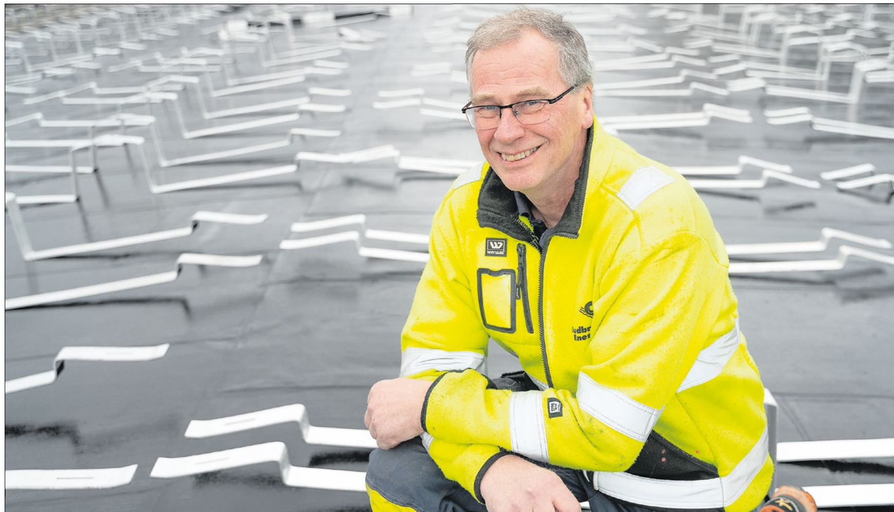
I GANG: Frank Jensvoll er driftsleder for GE-byggene og inviterer opp på taket for å vise at arbeidet med solcelleanlegget er i gang.
