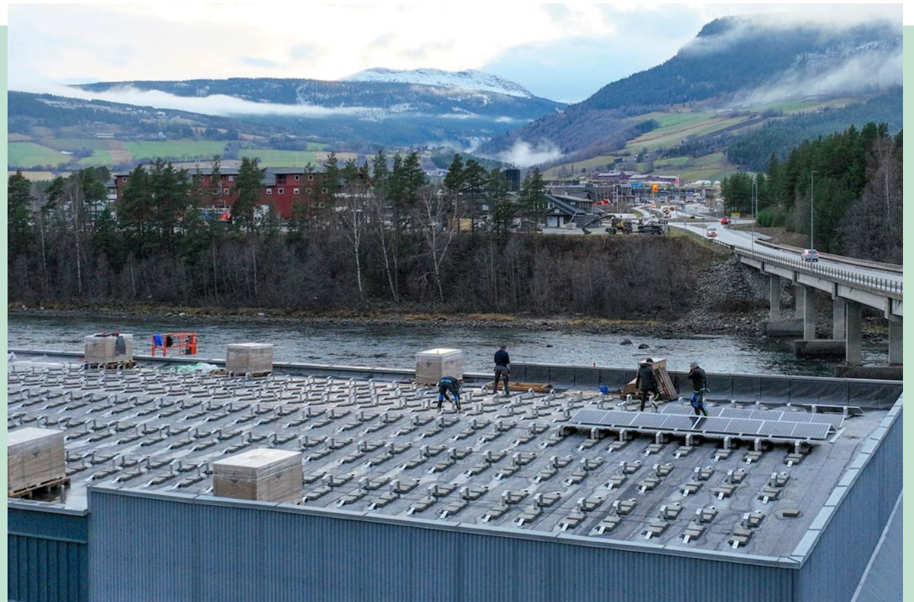
Montering av solceller på lagertaket på Vinstra. Foto: Kjetil Rannstad
