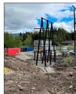
Ny kabelmast fordeler strømmen mellom Ringebru og Tretten.
