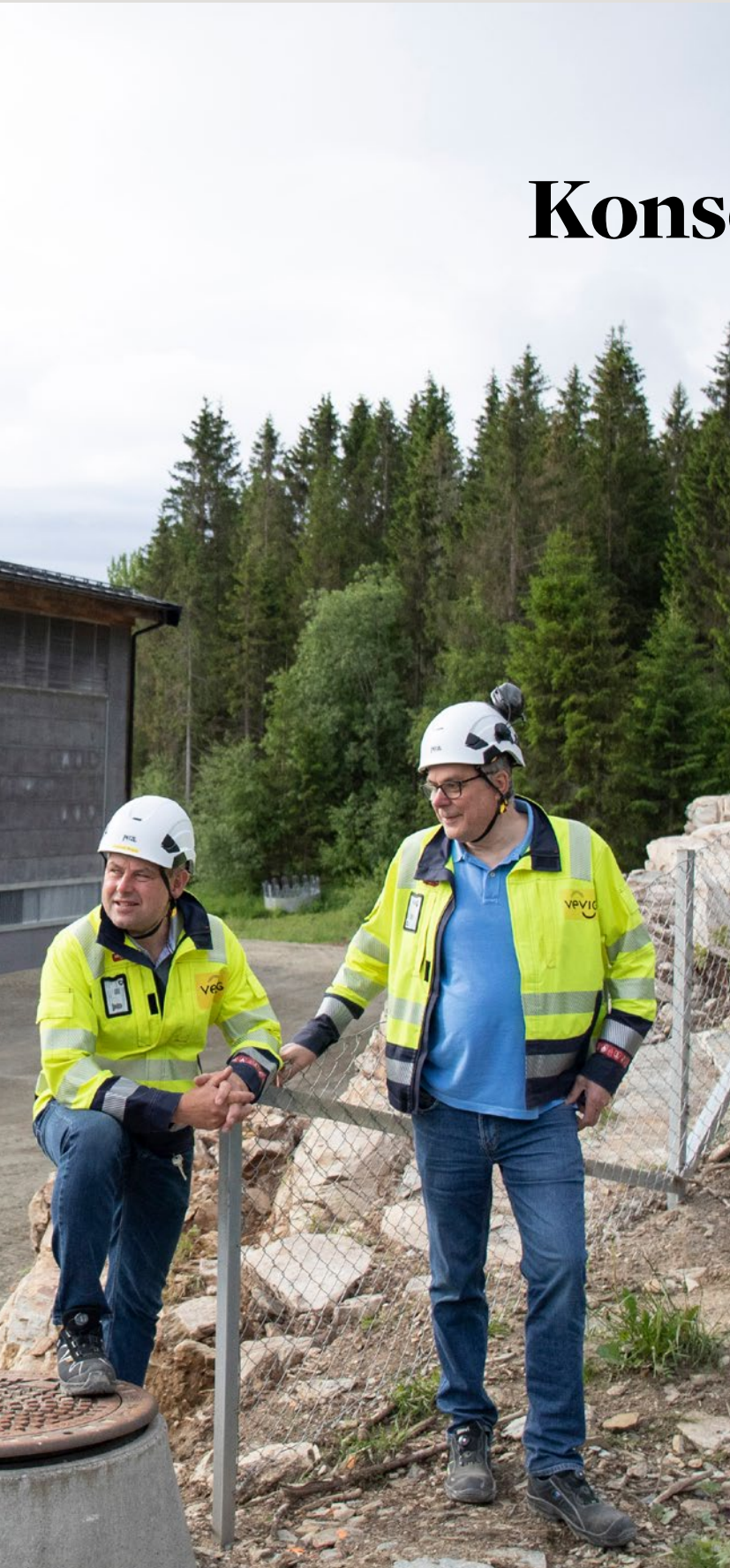
Prosjektleder Arne-Ivar Myrvang og daglig leder i Vevig Johannes Bergum ved den nye Fåvang trafostasjon. Foto: Nils Ormvold
