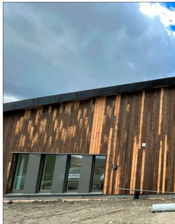
Noe av panelen som er behandlet med jernvitrol, har ikke tatt farge. Dette skal rettes opp i løpet av sommeren, opplyses det. ALLE FOTO: BEATE HOVDE
