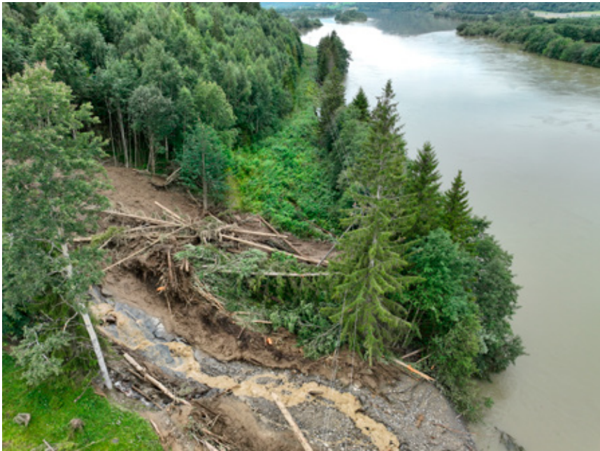
Fra ekstremværet «Hans» i august 2023. Ras på vestsiden av Lågen tok med seg høyspentlinja. Dronefoto: Kjetil Rannstad.
