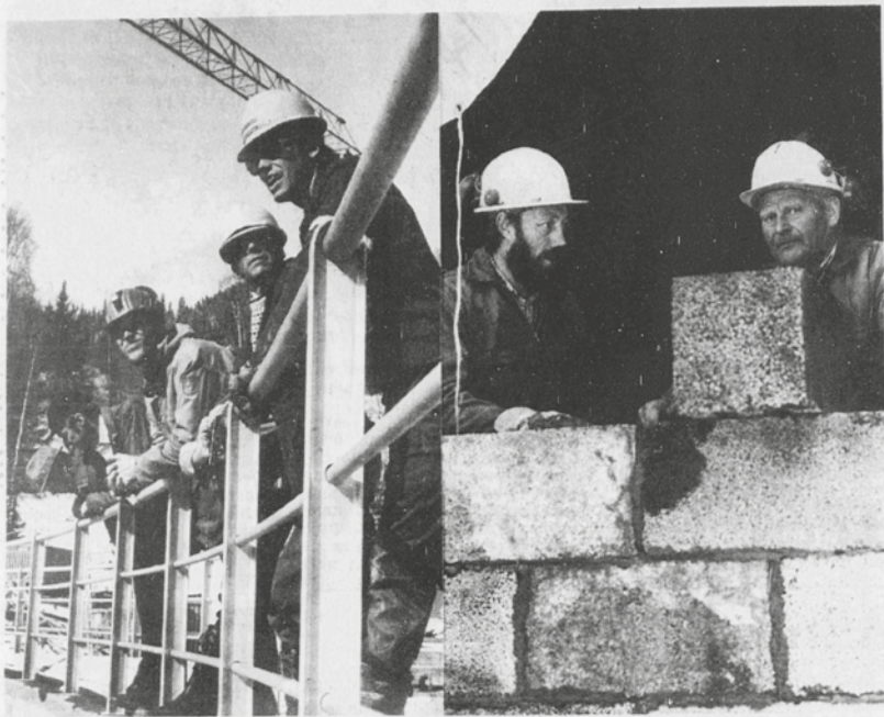
Gutta på brua og gutta på gulvet. Elverksjef Johs. Sviggum, driftsingeniør Nils Johan Todal, anleggsleder Per Nautvik, geolog Jan Rohde og byggleider Tormunn Skarstad ser såre fornøyd ut på toppen av demningen. Vel 40 meter under dem er Arnyfinn Hagen og Johannes Løften iferd med å mure igjen åpningen til tilslagstunellen.
