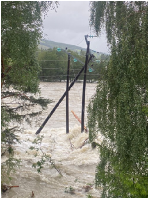
Fra ekstremværet «Hans» i august 2023. En høyspentmast ødelegges av de enorme vannmassene i Lågen. Foto: Stian Furuheim
