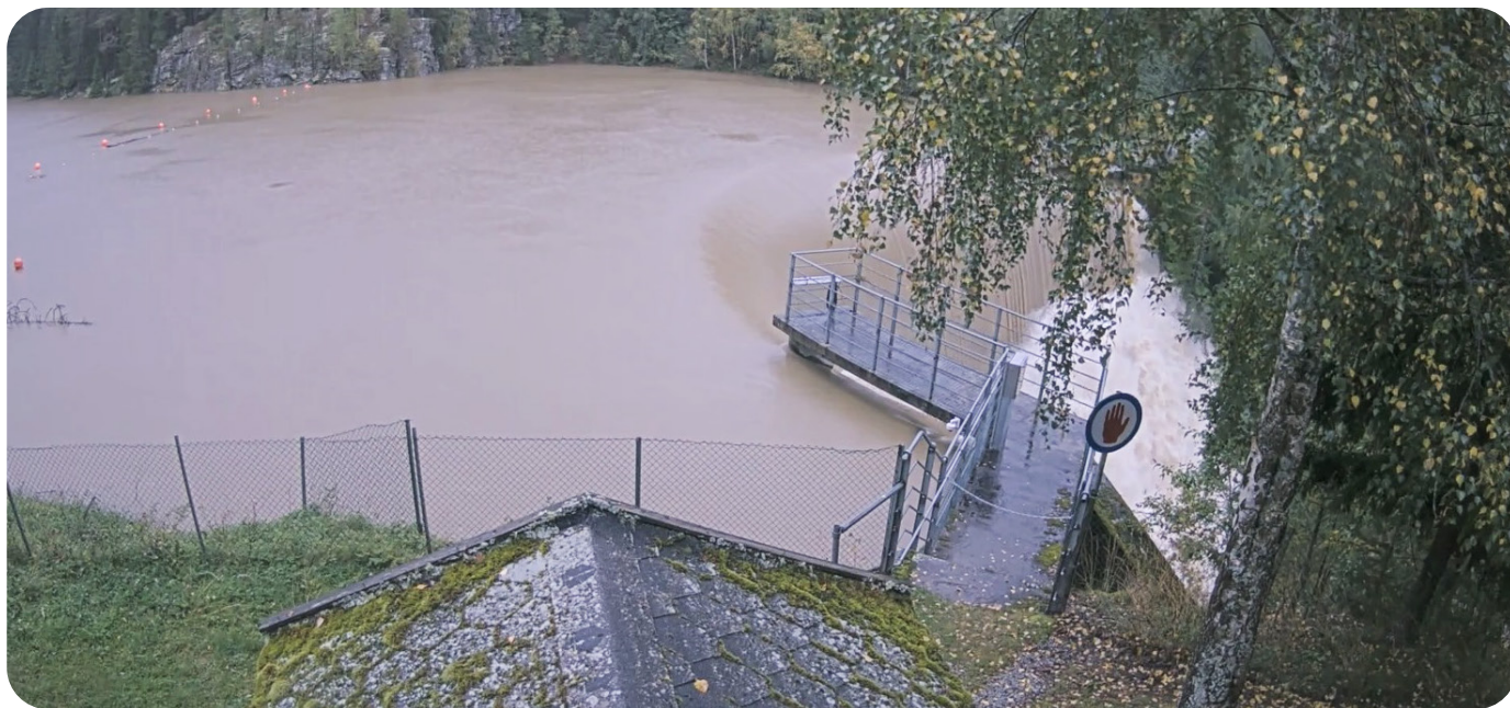
Ekstrem vannføring over Vinkelfallet dam under «Lille-Hans» 10. september 2024: 100 cm overløp, som tilsvarer 115 m 3 /sek. Større vannføring enn under ekstremværet «Hans» i 2023. Foto: Skjermdump Hafslund Kraft.
