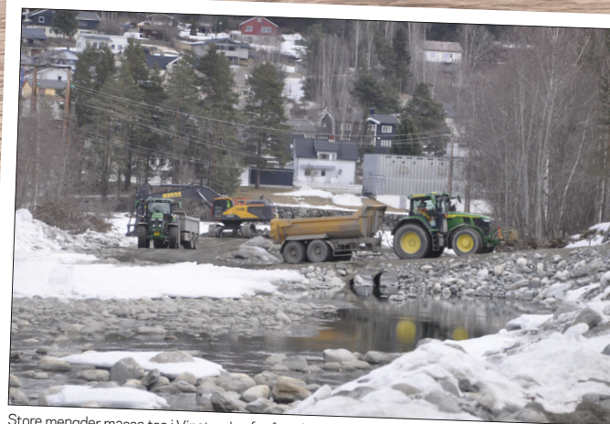
Store mengder masse tas i Vinstra elva for å endre elveløpet. ALLE FOTO: TOR LARSEN
