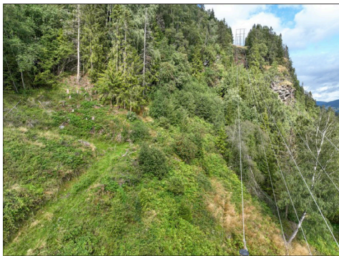
Her kom høyspentledningen i kontakt med lavspennet, på baksida på Fåvang. FOTO: VEVIG
