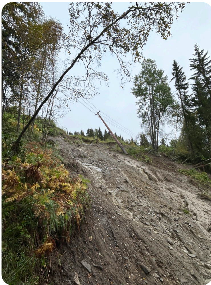
Ras har tatt ei høyspentmast i Brekkom under «Lille-Hans» i september 2024. Foto: Mats Sæther
