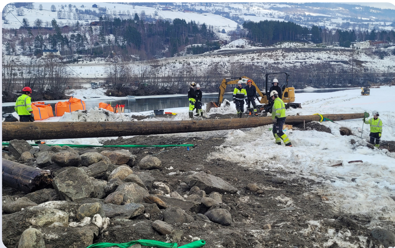
Reparasjon etter ekstremværet "Hans" i 2023: Montering av ny høyspentmast på Kviksøya i Sør-Fron. Foto: Ståle Rønningen
