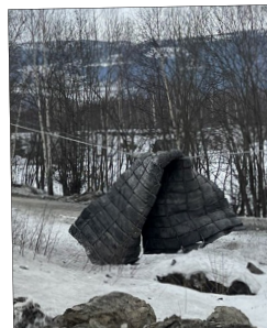
Sprengmatta havna oppå høgsentlinja. FOTO: GD-TIPSER
