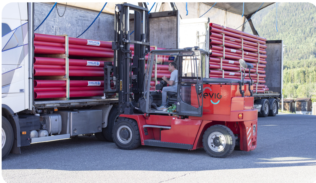
Anstein Brustuen lossrer rør for ny høyspentforbindelse til Hafjell-området.
