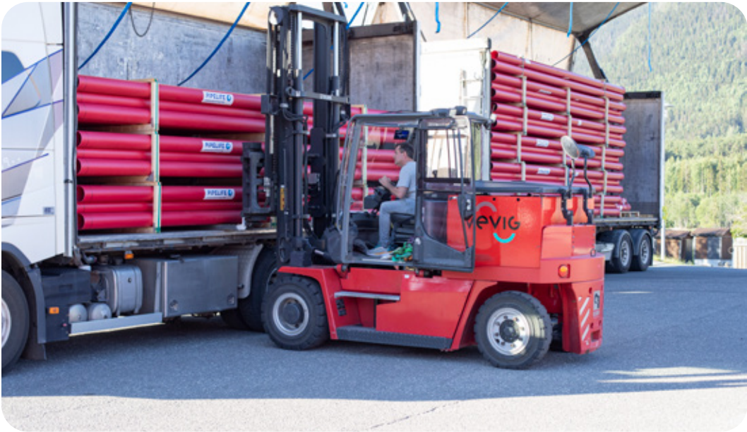
Anstein Brustuen lossrer rør for ny høyspentforbindelse til Hafjell-området. Foto: Nils Ormvold
