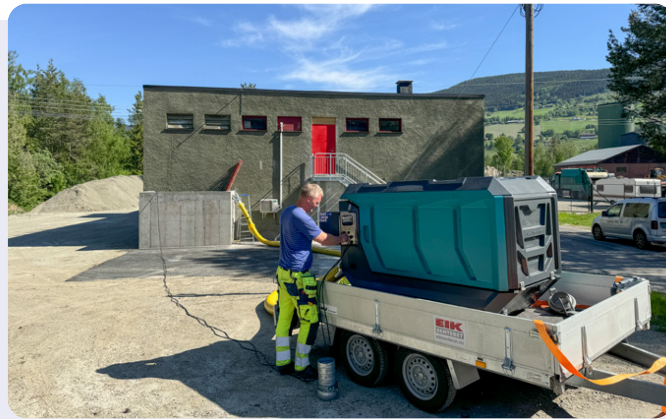
Tiltak etter ekstremværet «Hans» i 2023: Elektromontør Hans Sveipe tester ny pumpe-løsning for å holde flomvann ute av Ringebu trafostasjon. Foto: Arne-Ivar Myrvang
