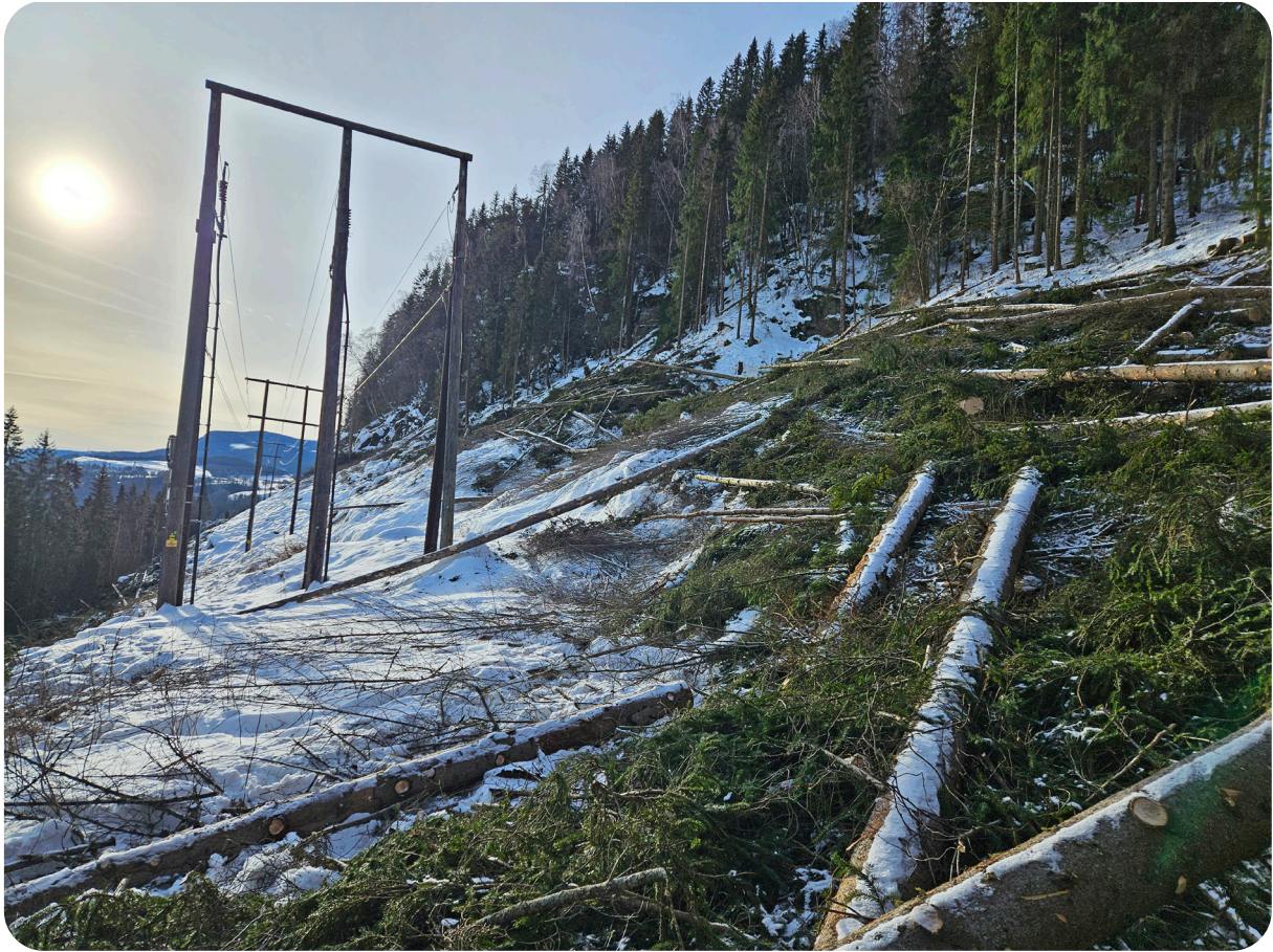
For å unngå strømbrudd pga. trefall i terreng med store høydeforskjeller er det gjennomført ekstra hogst ved høyspentlinjer i Fåvang. Foto: August Johan Evensen
