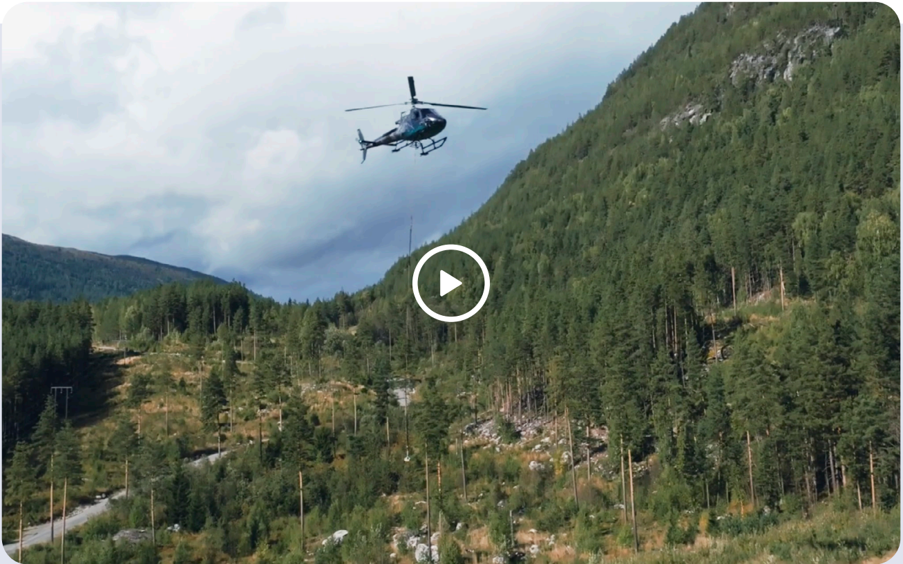
Forsterking av lavspentlinje i krevende terreng i Koloberget, der utstyr måtte transporteres med helikopter. Video: Synlig Bedrift
