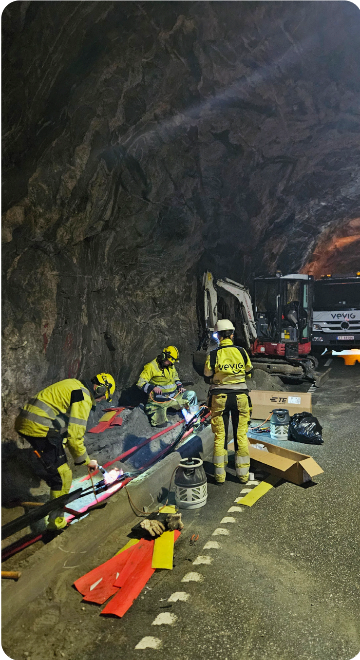
Reparasjon av høyspentkabel i Oppljostunnelen på Strynefjellet. Foto: Simen Toven
