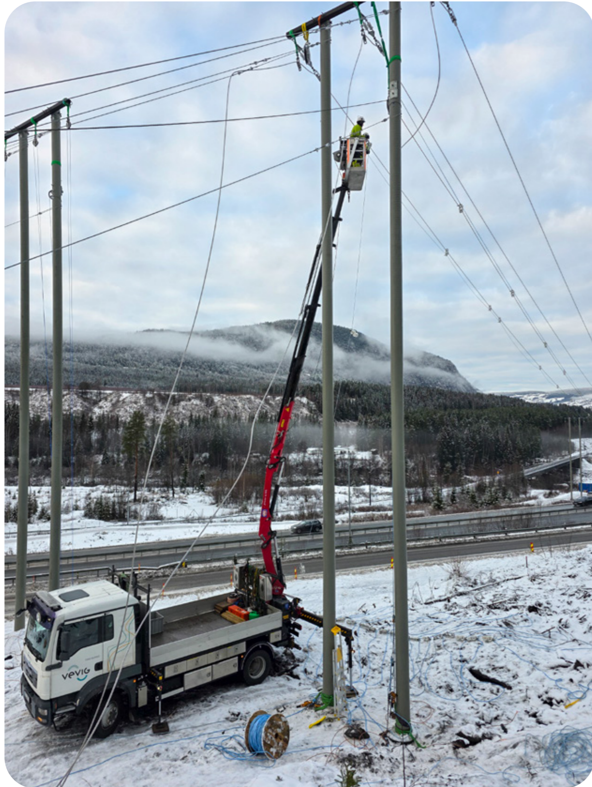
Bygging av ny høyspentlinje ved Hunderfossen, som vil gi økt kapasitet mot Hafjell-området. Foto: Henrik Endre Steinslien
