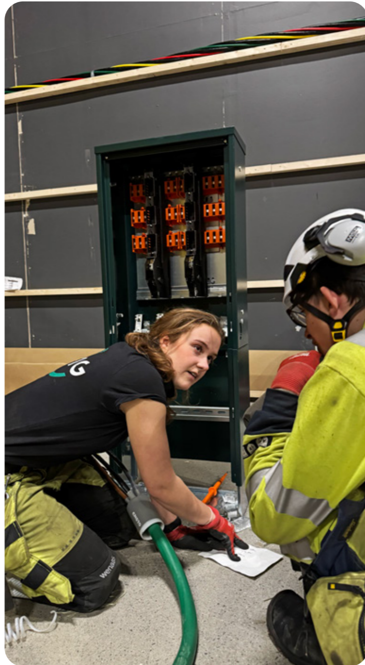
Fra byggingen av Energimontøren på Energisenteret, der bl.a. Elinor Payne Dybvik og Thomas Rundtom fra Vevig deltok. Foto: Energisenteret
