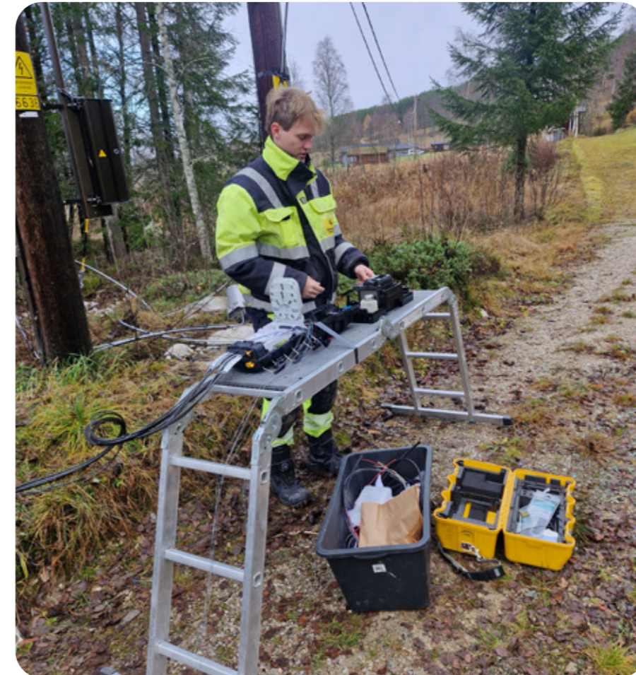
Amund Bakken skjøter fiberkabler i Rendalen. Foto: Kjetil Brendhaugen
