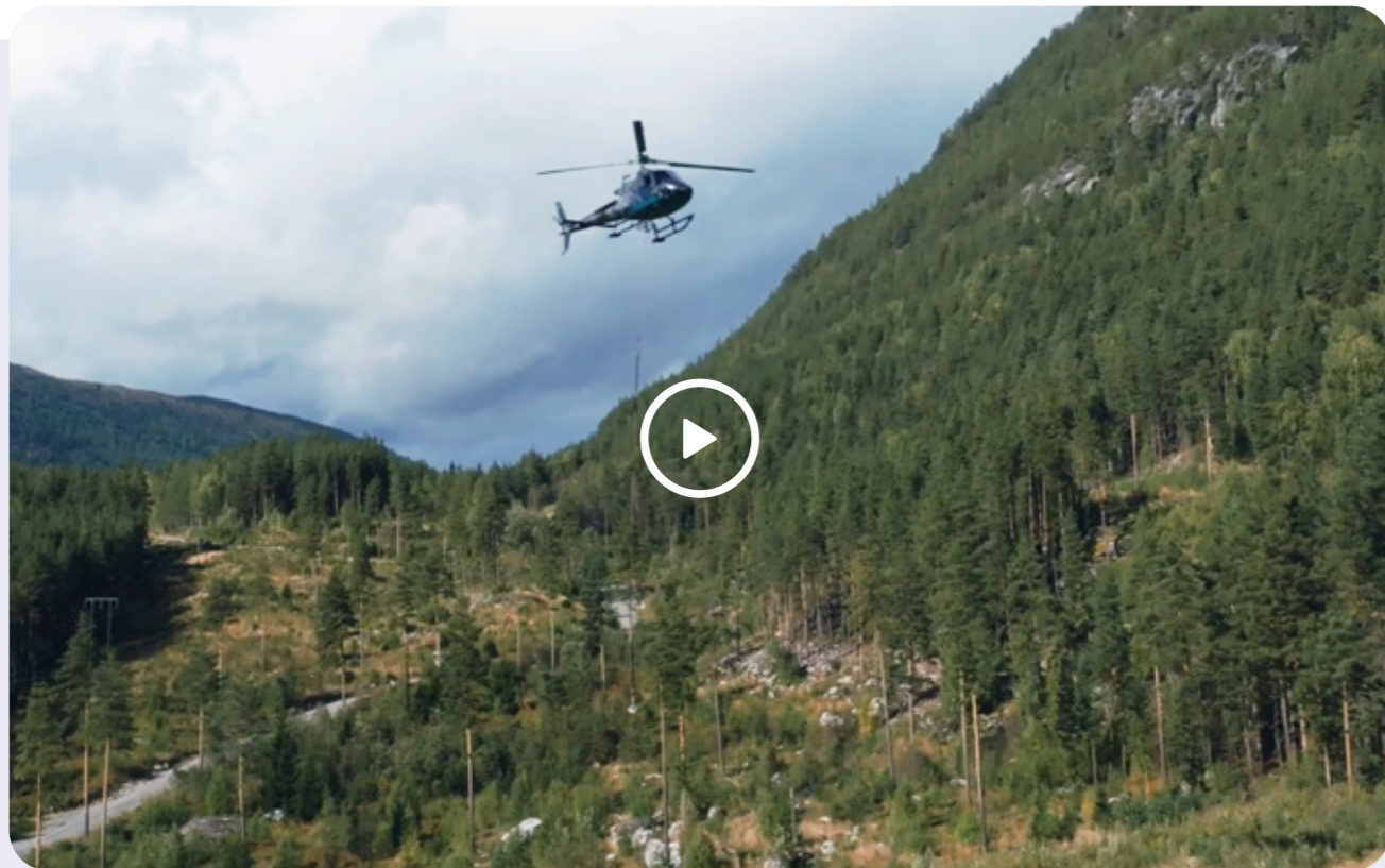
Forsterking av lavspenning i krevende terreng i Koloberget, der utstyr måtte transporteres med helikopter. Video: Synlig Bedrift
