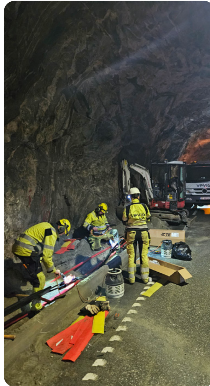
Reparasjon av høyspentkabel i Opplostunnelen på Strynefjellet. Foto: Simen Toven
